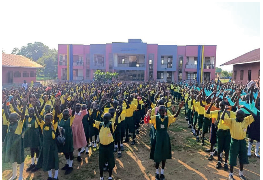
Schulkinder vor der Grundschule in Lologo, auf deren Dach nun stolz eine Solaranlage thront und die Schulgebäude mit nachhaltigem Strom versorgt. Foto: Caritas Auslandshilfe.
